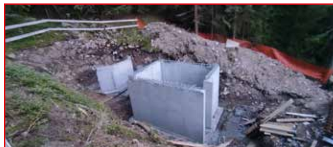
Òrbetn ver za paun a nais stuck va de bòsserlaitung ver de hittn
